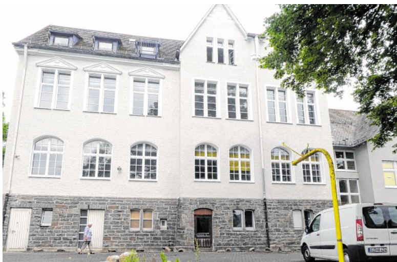
Die ehemalige Florenburgschule ist nun Sitz der Klimawelten mit Labor, Küche, Büro, Ausstellungs- und Veranstaltungsräumen. Mit-Mieter sind die Stadtwerke.
